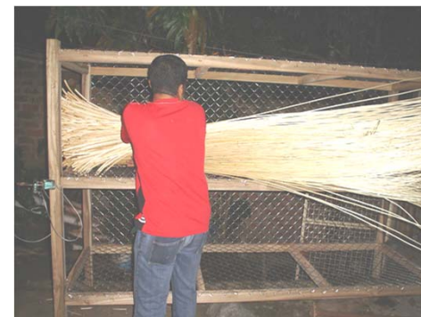
Construcción de estructura para almacenamiento Ibaguè - Tolima
