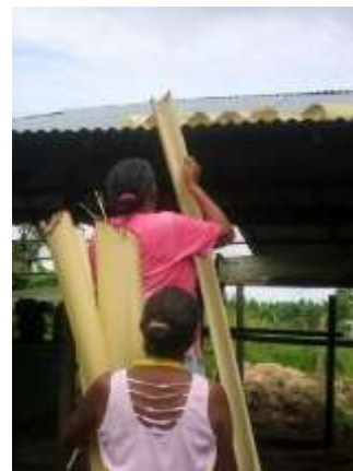
Colocación de las "canoas" verdes sobre techo de zinc
