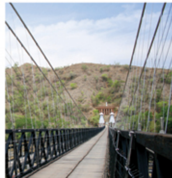
Puente de Occidente
