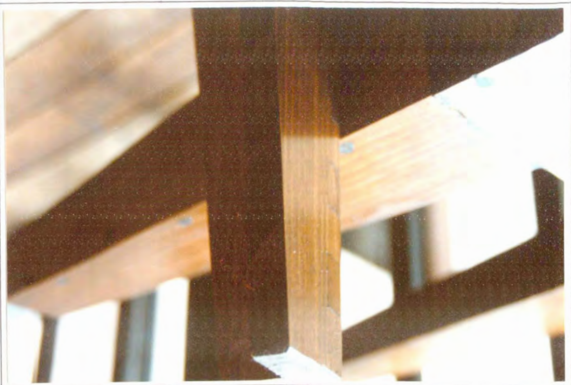
Detalles estructurales de las mesas auxiliares Butacas: Dilatación abierta y dilatación cerrada, ensamble tarugado. Taller del Artesano Justo Pastor Mora
