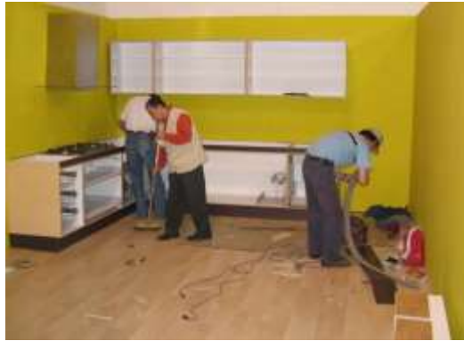
Montaje Instalación Cocina, La Petite Cocinas. Camilo Aldana
