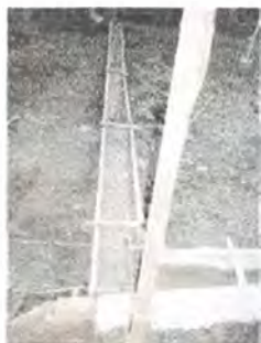
Elaboración de la viga de amarre. Sampues. Fotógrafo: Omar Darío Martínez G. Artesanías de Colombia. Noviembre 2006.
