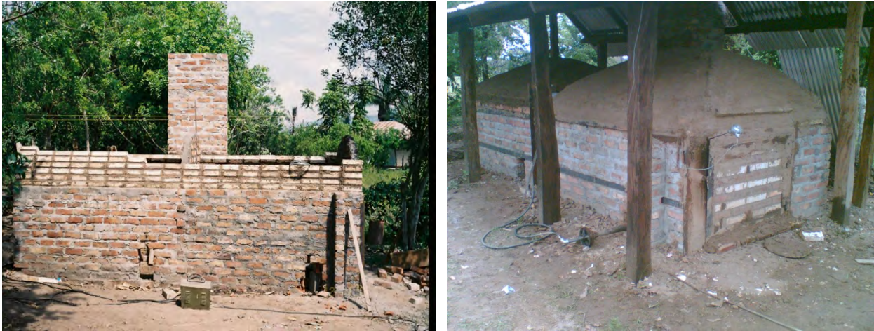
Fotos 5 y 6 – Construcción Horno piloto a Gas Combustible – Javier E. Guerrero.
