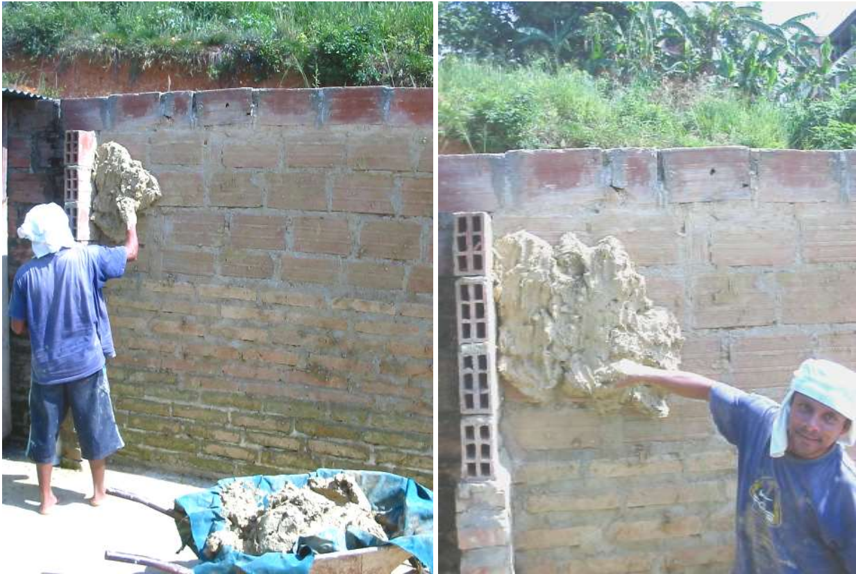
Colocado sobre el muro para secado Una vez endurecido se retira del muro
