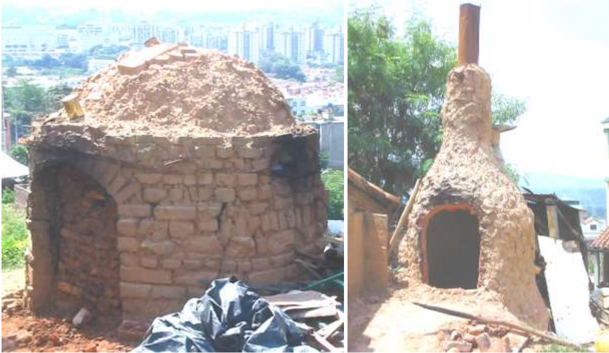
Horno Grande de Ladrillo de adobe Horno Mediano, recubierto de barro
