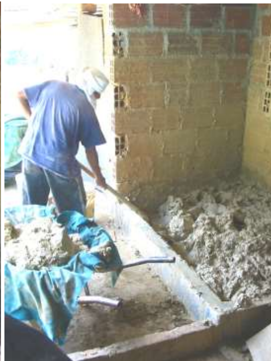
Extracción del tanque para almacenaje
