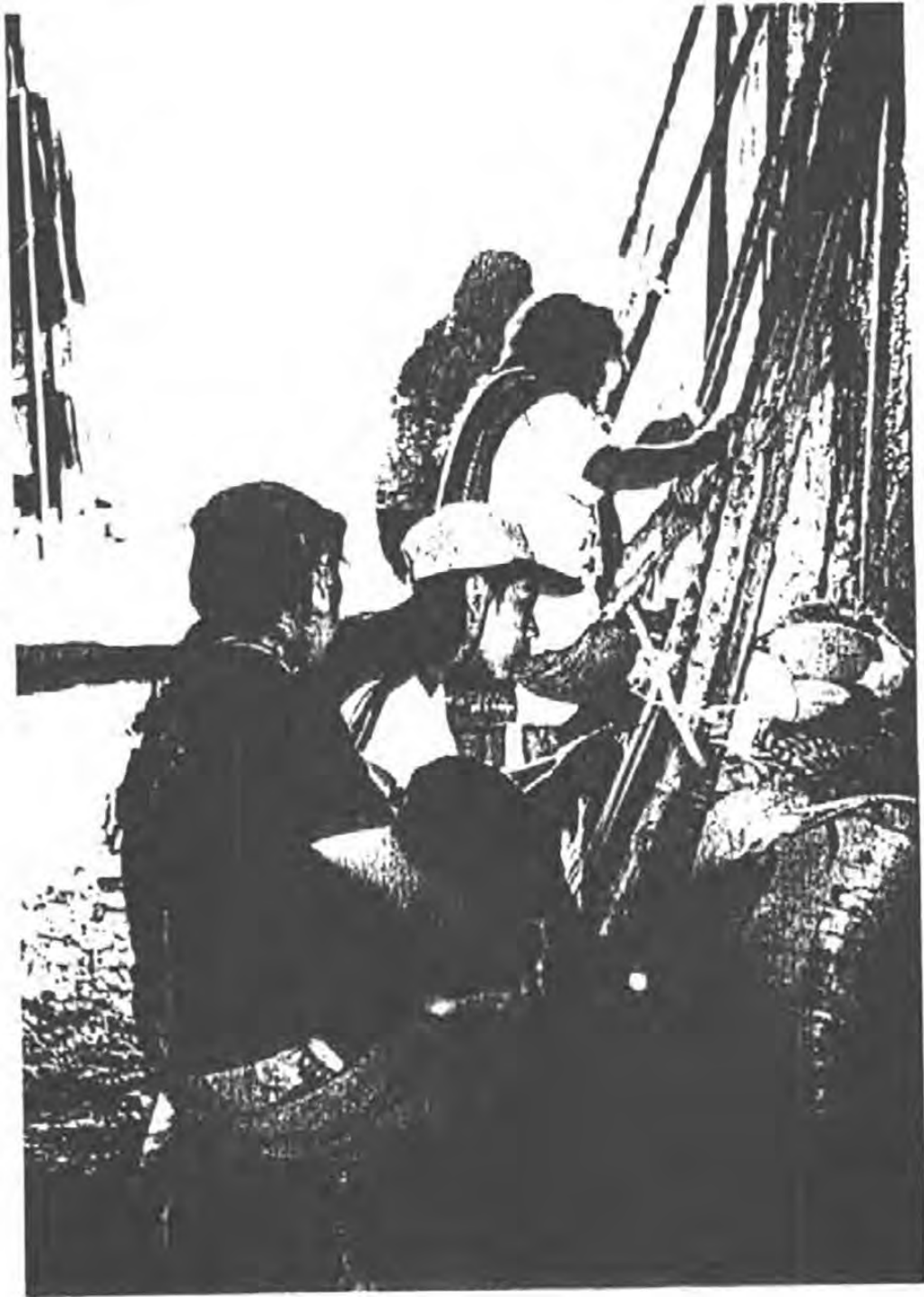
TALLER UBICADO DENTRO DE CASA EN CONSTRUCCION
