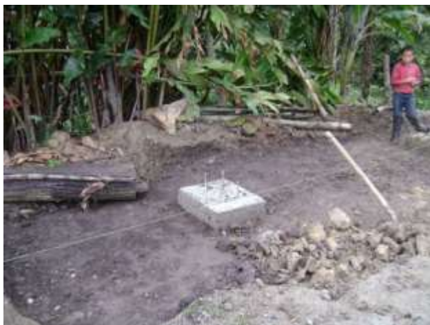
Foto 11: nivelado definitivo para el establecimiento de las columnas en guadua estructural sobre cada una de las zapatas
