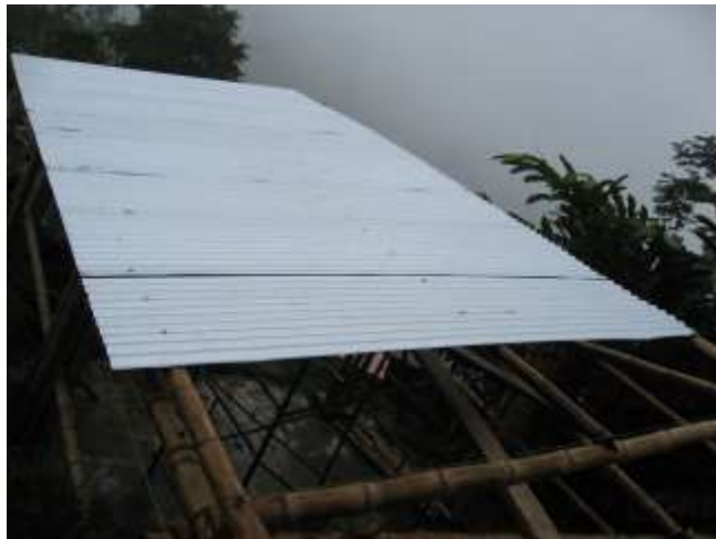
Foto 13: vista en detalle entechado en teja de zinc
