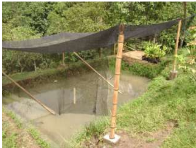
Foto 6: obra terminada del estanque para el empozado de mimbre
