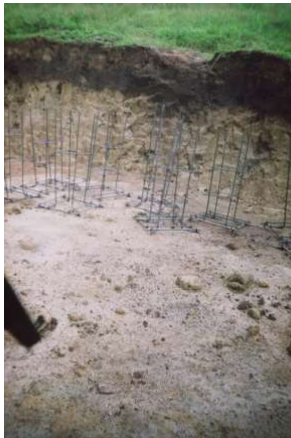
Foto 8: elaboración de canastas en hierro para la estructura de zapatas
