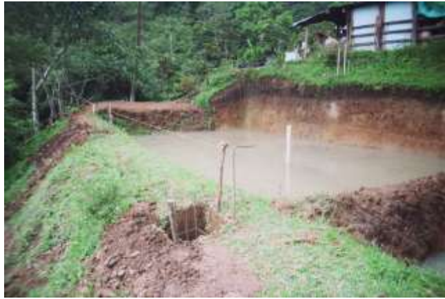
Foto 4: alineado de la excavación para el fundido de zapatas en el perímetro del estanque
