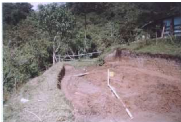
Foto 2: obra para la instalación de la tubería de desagüe del estanque
