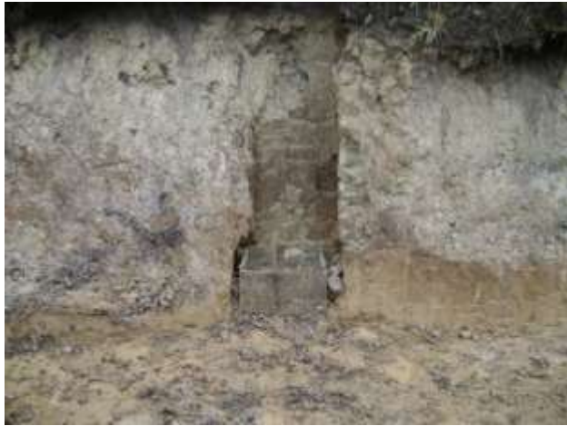
Foto 9: detalle de zapata completamente fundida. Planta de descortezado de mimbre
