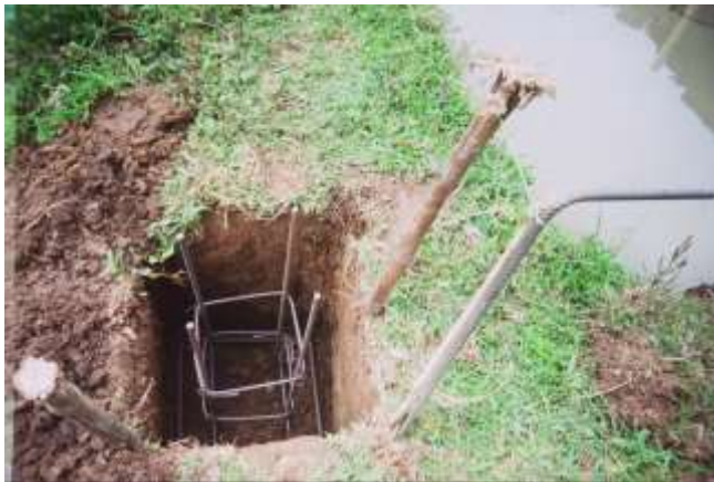
Foto 5: detalle del excavado para base o zapata
