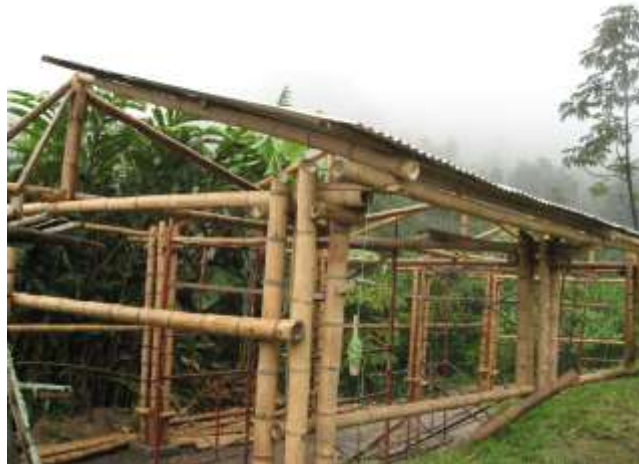
Foto14: detalle estructura sitio para el descortezado de mimbre, primer plano columnas
