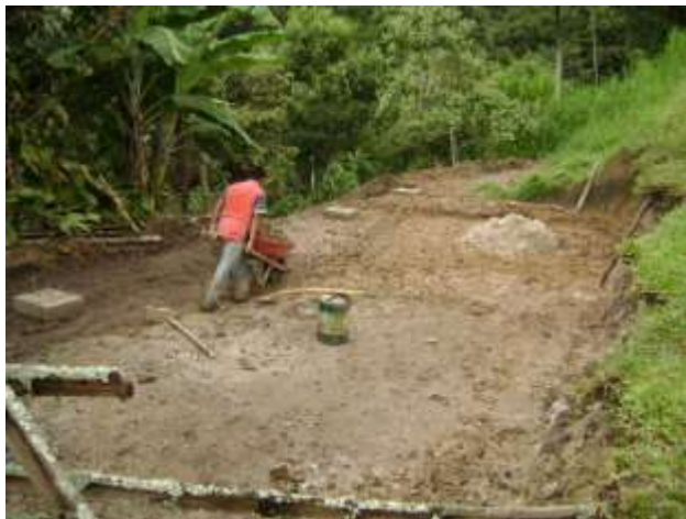
Foto 10: trabajos de nivelación del piso. Planta de descortezado de mimbre
