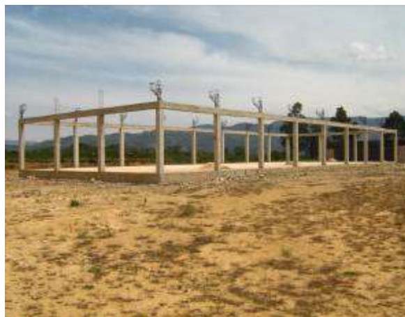
Construcción de ASOAGUABUENA
