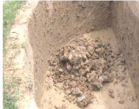
Foto lugar de humectación de arcillas
