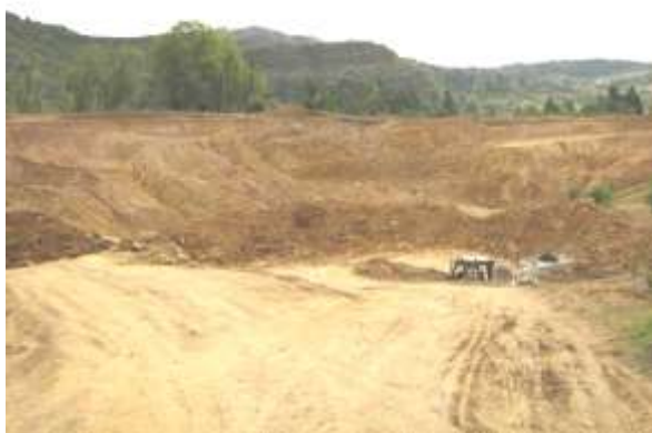
Foto Mina de Arcilla sector Resguardo Occ.
