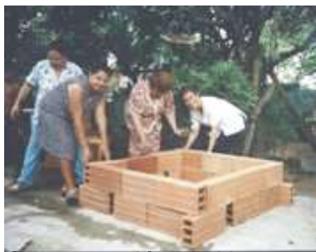
Construcción del horno de ladrillo sencillo (2002)
