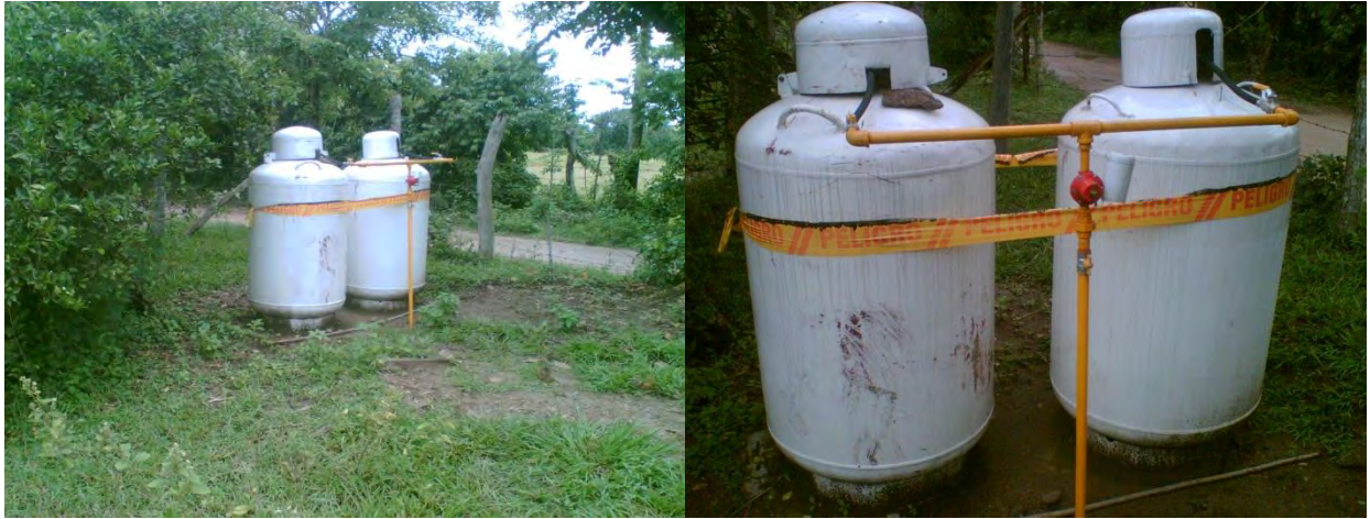
Fotos 7 y 8 – Instalación Tanques de Gas L. P. de 100 galones c/u – Javier E. Guerrero.
