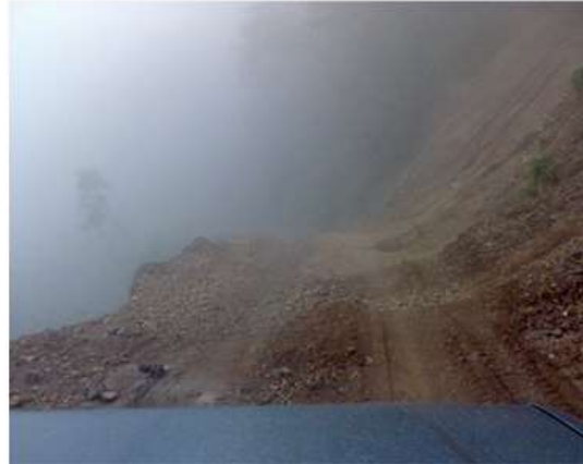
Condiciones de la vía de acceso
