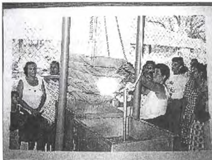
Funcionamiento de la caldera, antes de la adecuación actual.
