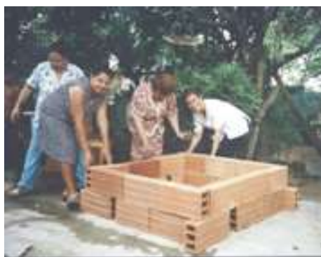
Construcción del horno de ladrillo sencillo (2002)
