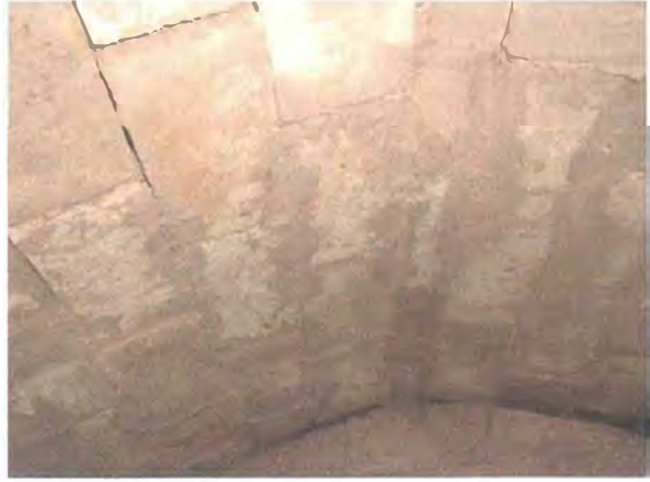
Foto 118 Techo abovedado del Horno
