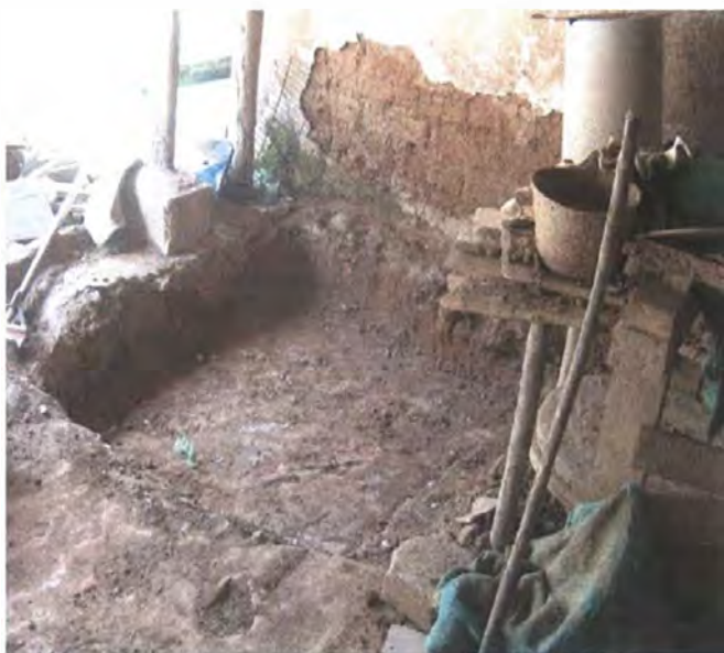
Foto 30 Preparación para Placa Cemento.
