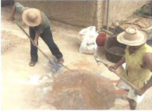
Foto 25 Mezcla de Mortero
