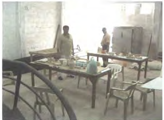
Foto 36 Interior de bodega donde esta el horno
