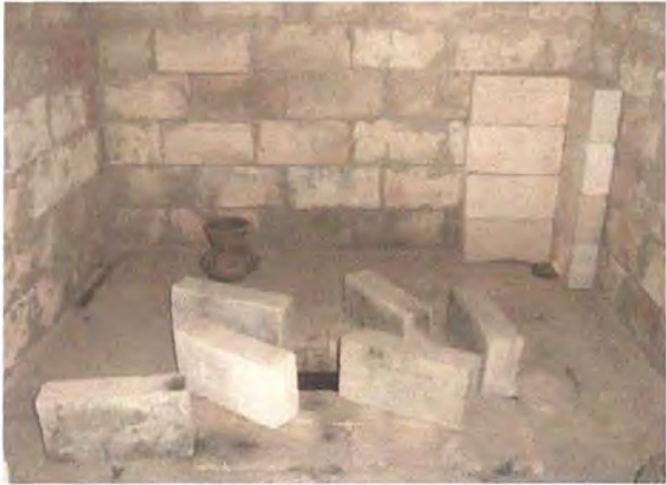
Foto 117 Piso en ladrillo refractario
