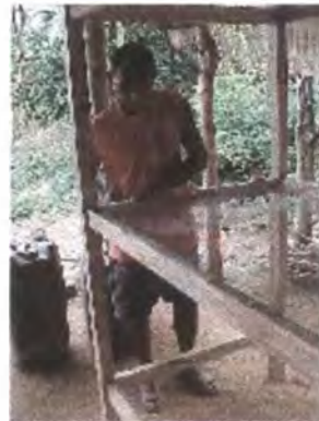
Colocación y templado de la malla metálica.
