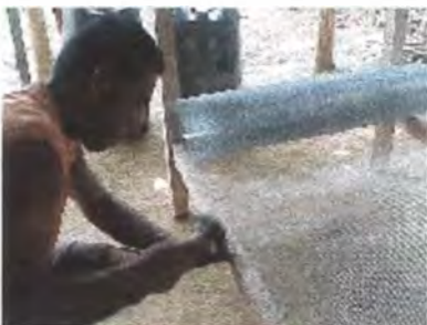
Templado de la malla metálica
