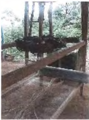
Estructura terminada y disposición de las tiras de bejuco
