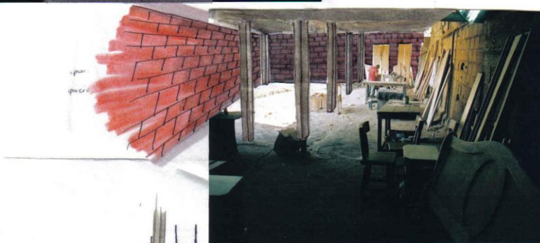
Encerrar el espacio para evitar contaminación al ambiente
