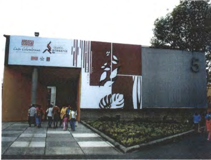
Fachada Casa Colombiana 2007. Diciembre 2006. Foto: Orlando Rozo
