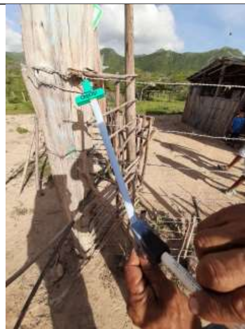
Implementando pinturas no tóxicas, ganchos y espuma para mejor aplicación de pintura.
