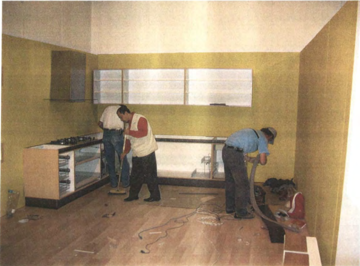
Instalación de Cocina proveída por La Petite Cocinas. Camilo Aldana.
