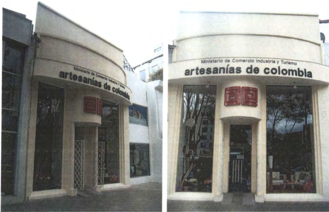
Fachada almacén del Norte. Foto: Camilo Aldana, Laboratorio Colombiano de diseño 2006
