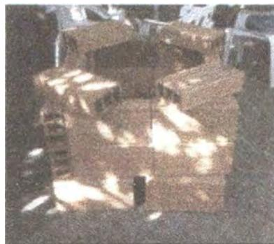
En las fotografías, se muestra la construcción del horno de ladrillo de bloque común
