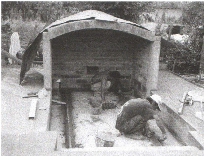
Fijación de rieles para el carro
