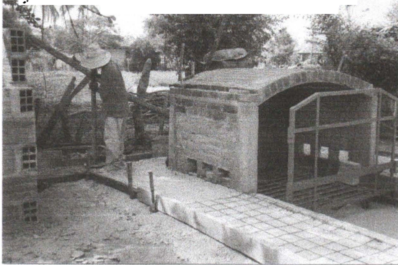
Construcción and en es de carga y descarga
