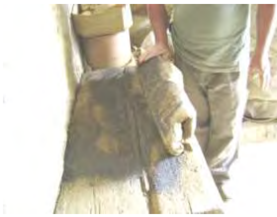
Amasado de Arcilla con arena de río
