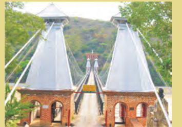
el puente de occidente
