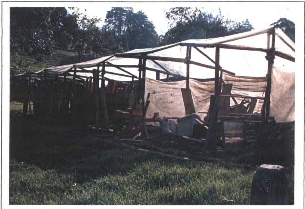
FOTO # 10 | DEPOSITO DE MADERAS / COMERCIAL DE MUEBLES
