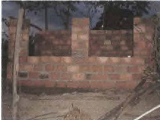
Construcción centro de tinturado. Foto Luz Dary Rosero Feb 2007
