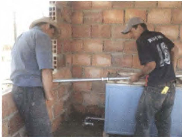
Instalación de tubería para desagüe. Foto Luz Dary Rosero Feb 2007
