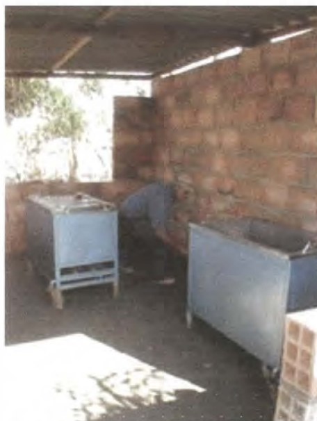
Instalación de equipos. Foto Luz Dary Rosero Feb 2007
