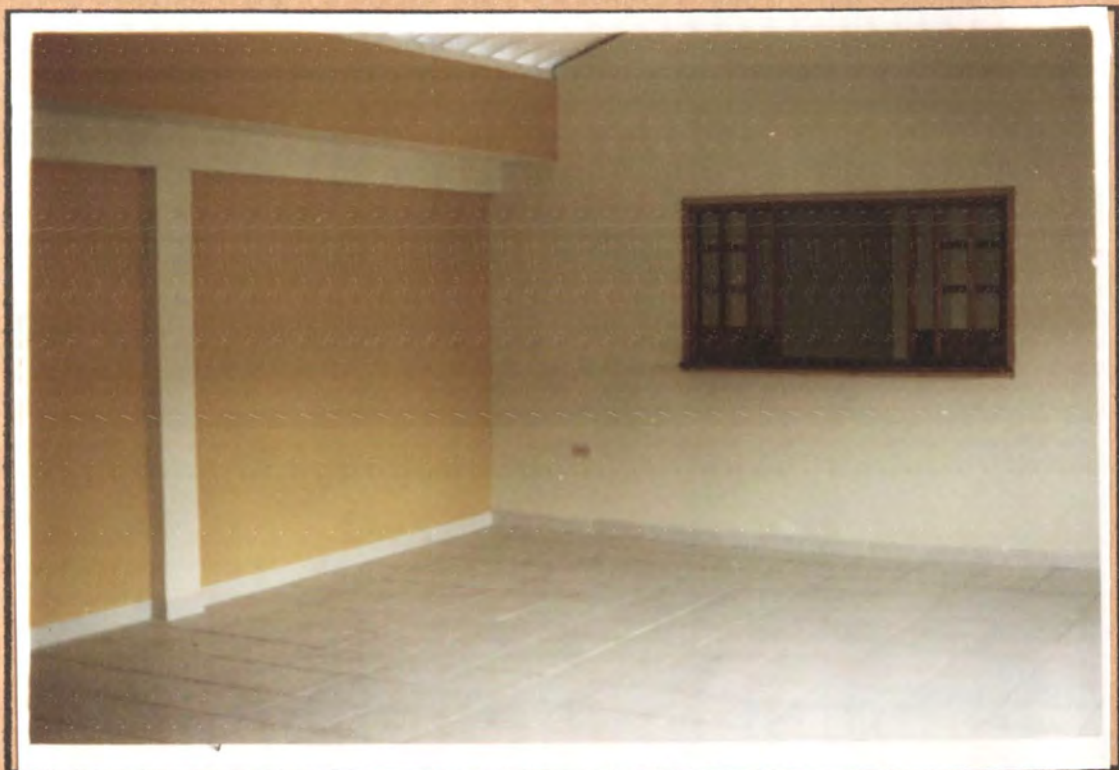
Vista posterior del salón de la Casa de la Cultura. En el fondo se observa una ventana que lo comunica con un pequeño cuarto.
