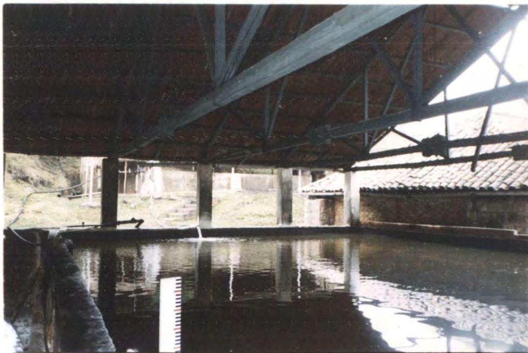
Centro hidráulico de procesamiento de la mina de sal.
