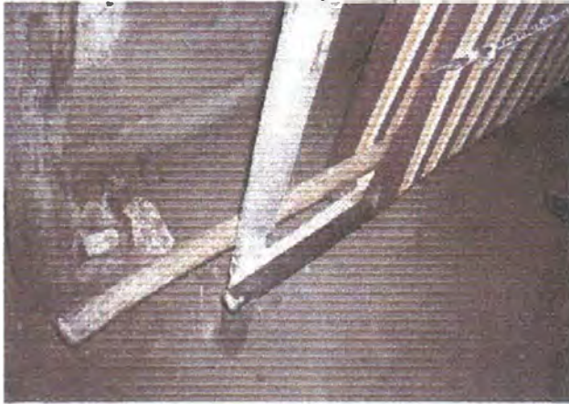
Forma de anclaje de los parales al piso y techo
