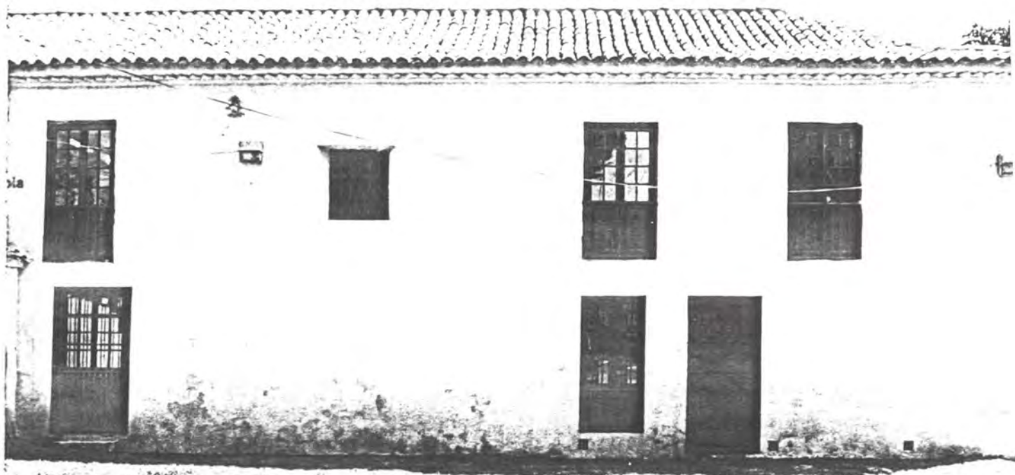
Continuación fachada occidental claustro.
