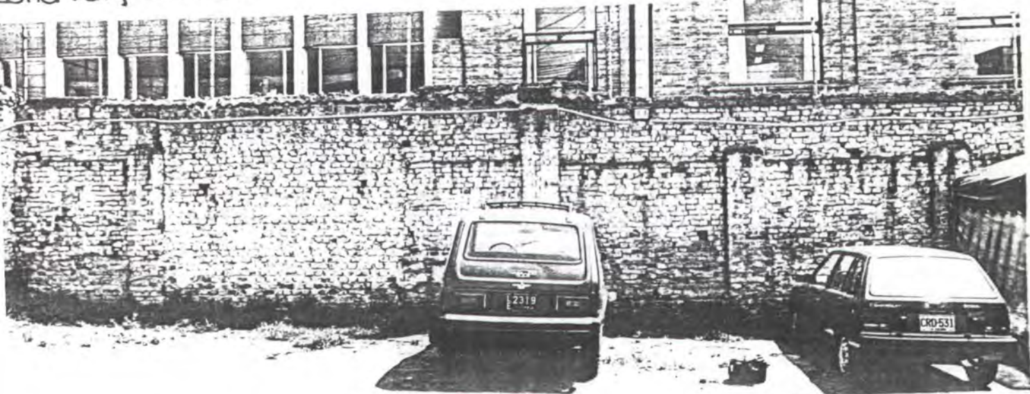
Esquina sur-occidental. Muro límite este (vista interior)
