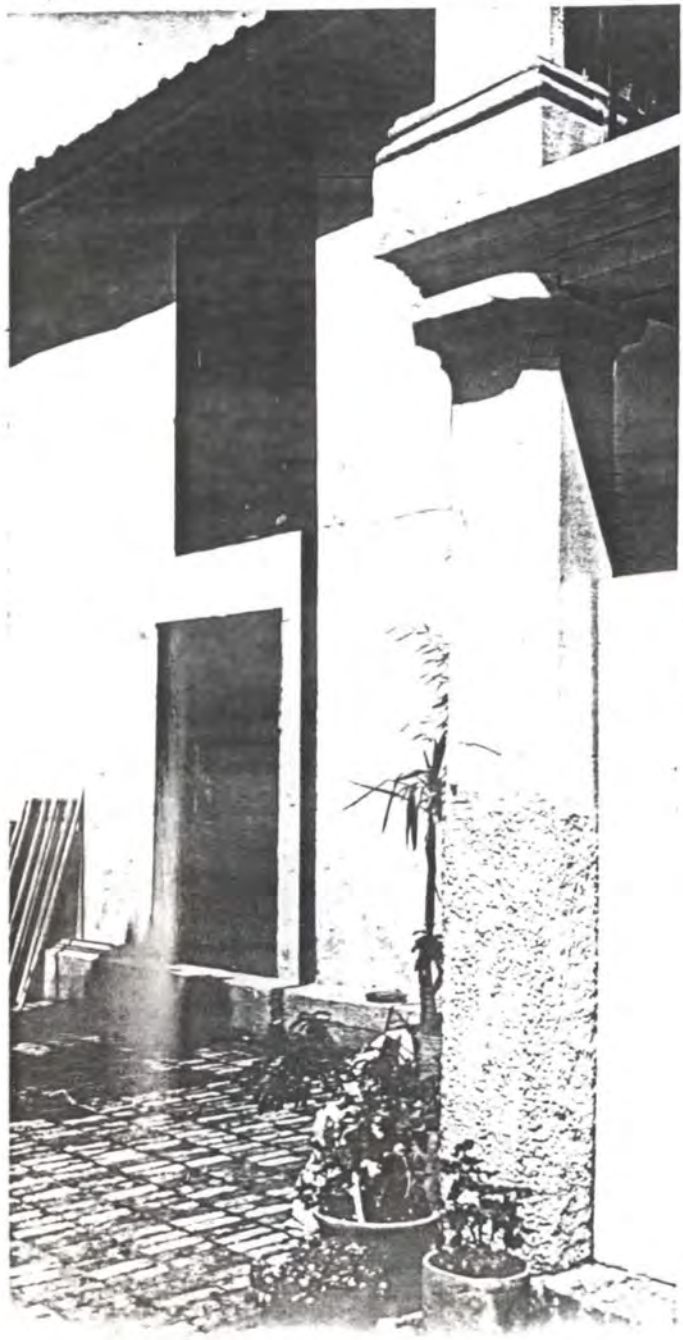
Detalle de columna de época republicana. Fachada sur.
