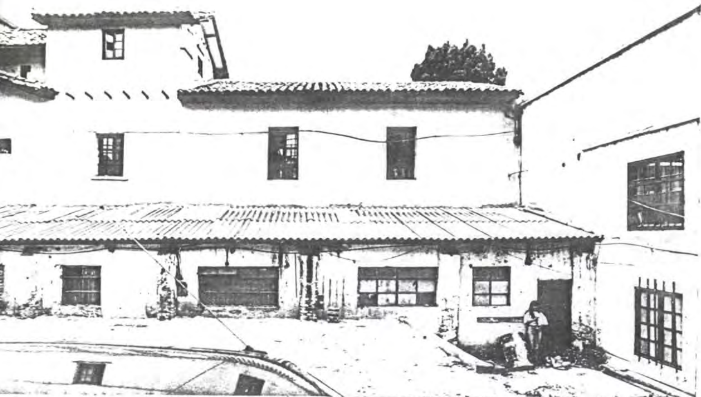
Continuacion lado sur.
