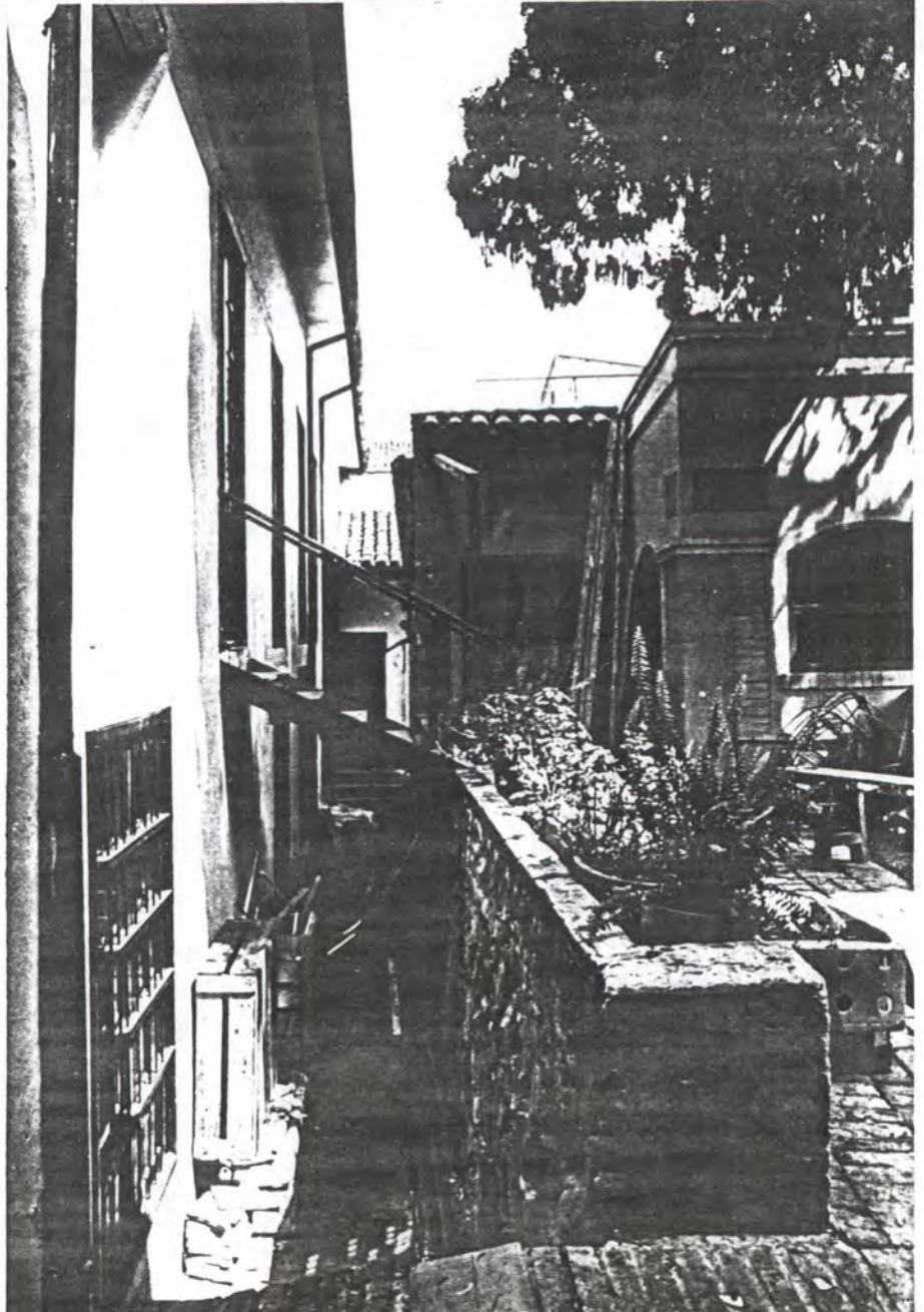
Zanjon de acceso a depósito de canastos (antigua cocina del colegio de monjas) en el lado occidental del patio republicano.
