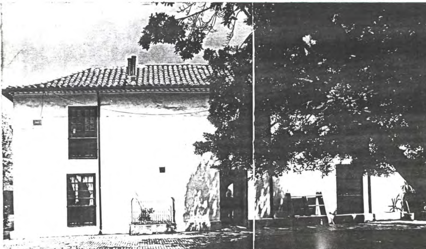
Fachada sur del claustro y adiciones de época republicana.
