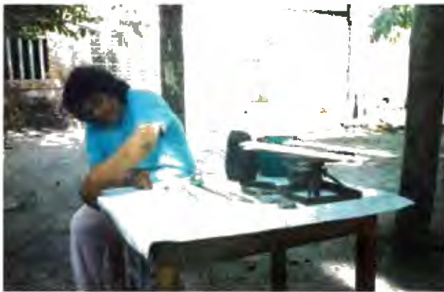
Implementación de formaleta de madera.
