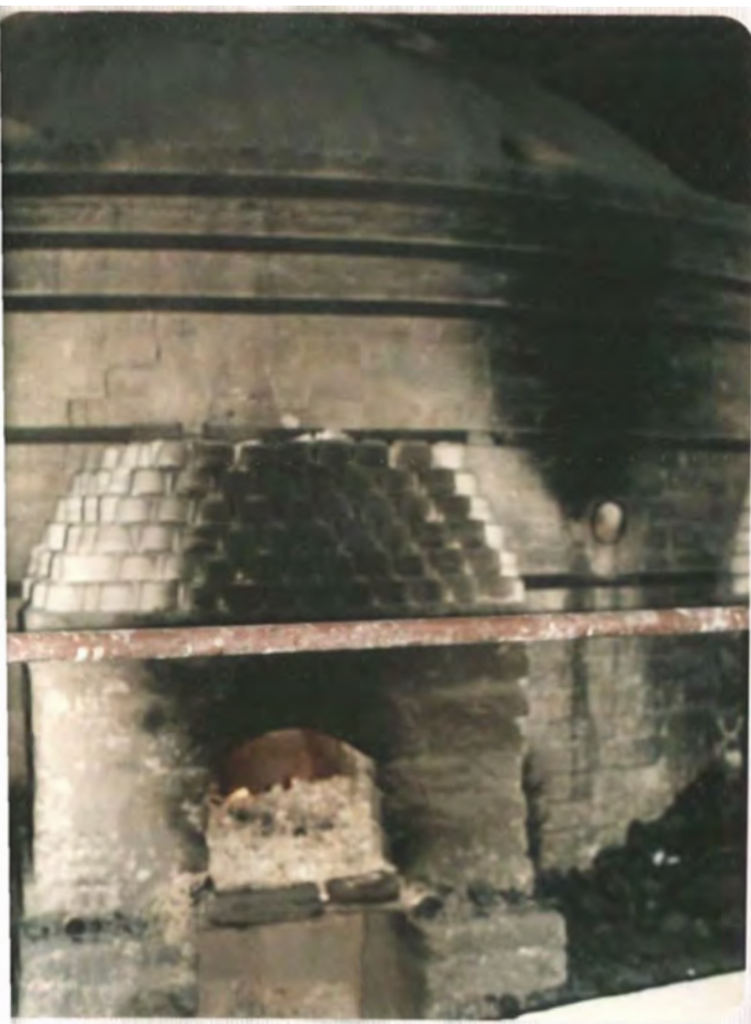
103. Detalle de horno enfriando, en primer plano Fogón o alimentador del horno.
