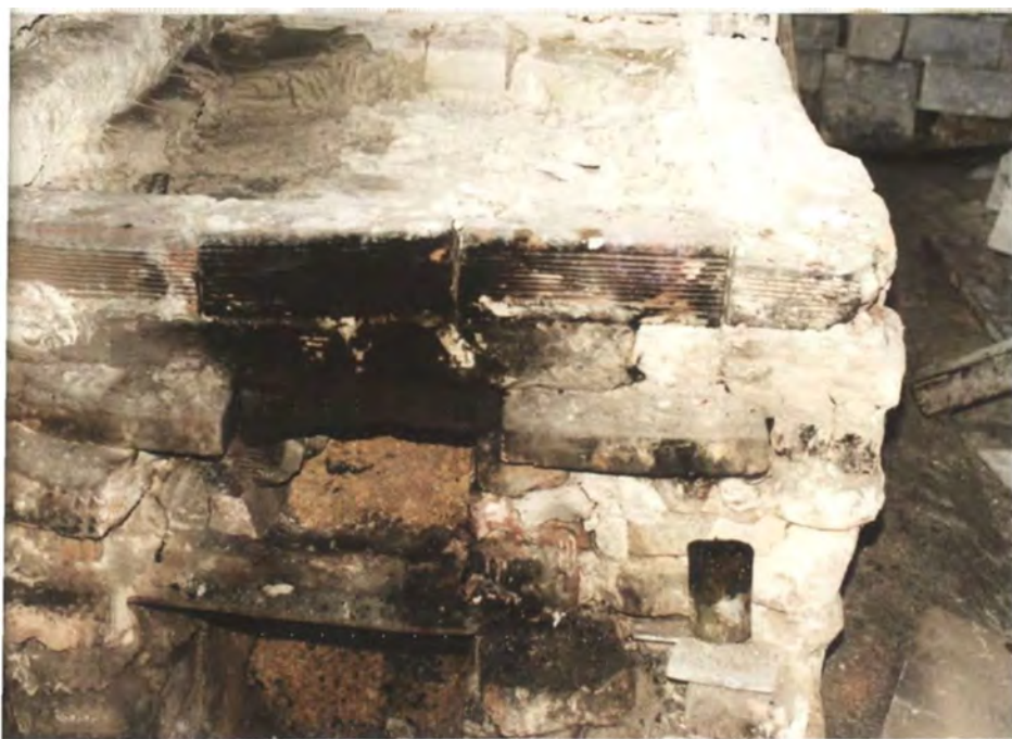
45. Estufa de secamiento. Consiste en una especie de horno abierto y de poca profundidad sobre la cual se riega la pasta semilíquida y por medio de calor se termina de extraer el agua a la pasta. Detalle de fogón Taller Artesanías El Progreso
