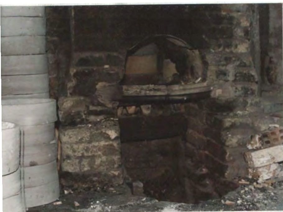
138. Detalle de fogón o alimen- tadores. Observe- se el piso y en- trepiso de su interior.
