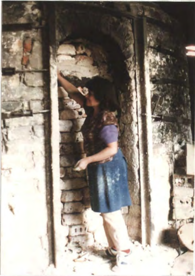
100. Cerrada o tapiada del horno
