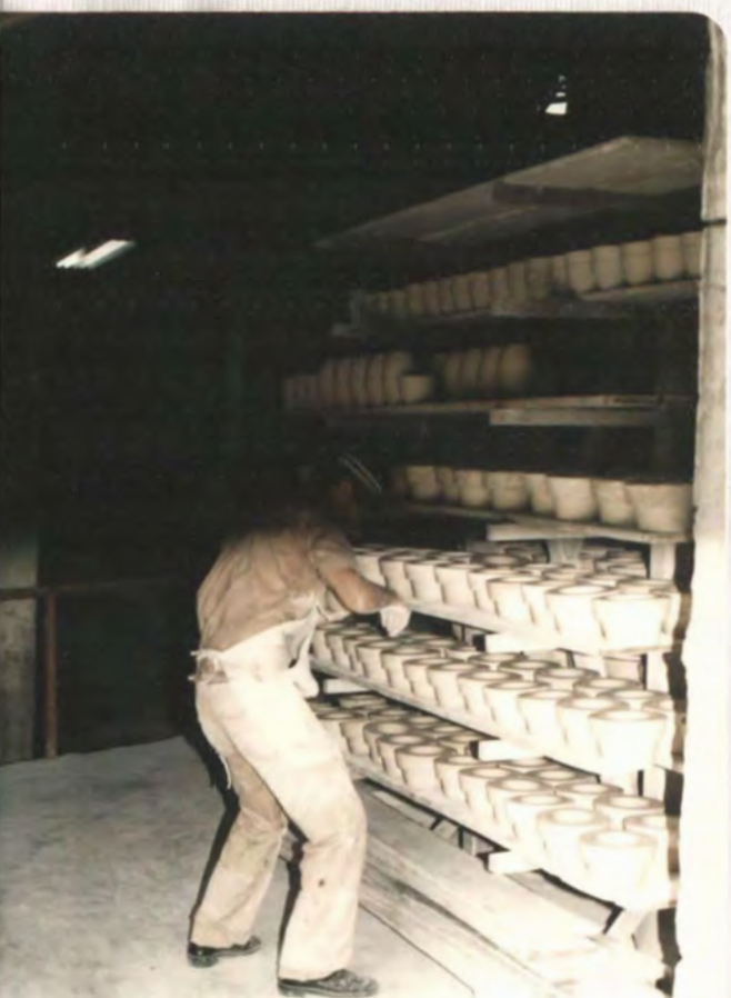
83. Organización de moldes para secado. Fábrica Conti- nental
